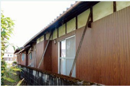
1-3-24 伊勢湾台風後に固定された支柱
