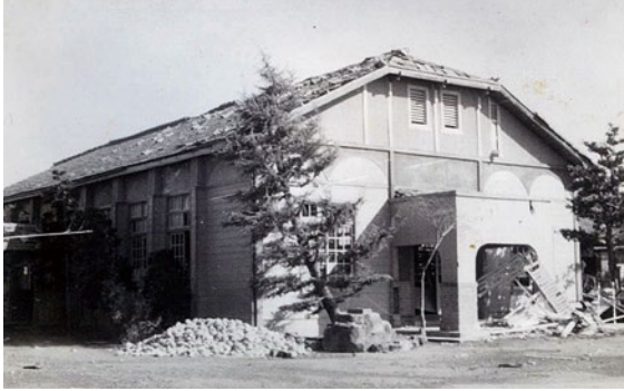
1-3-22 大口南小学校講堂 瓦は飛ばされ、出入り口の破損も激しい 〔伊勢湾台風関係書類綴 大口南小学校〕 大口町歴史民俗資料館所蔵
