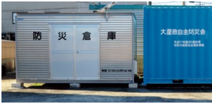
3-1-21 大屋数学習等共同利用施設内防災倉庫
