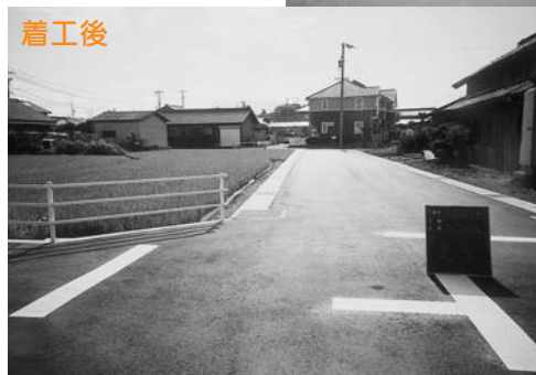
河北二丁目地内の道路新設工事
