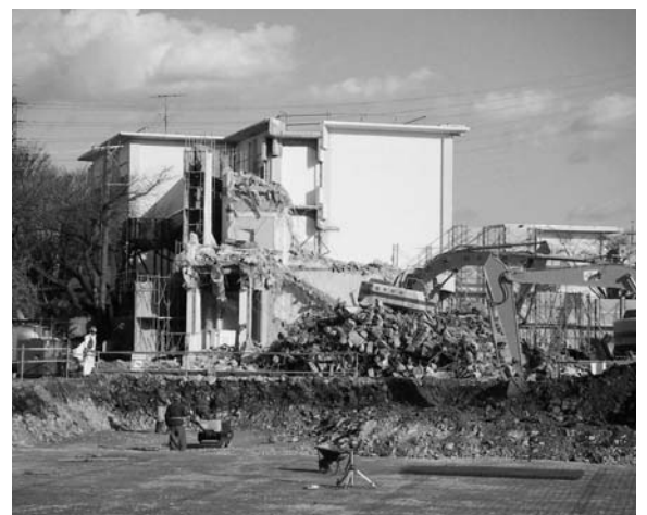
アスベスト除去後、解体されコンクリート片になった西館校舎＝平成18年12月
