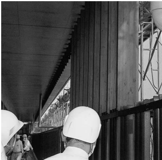
木製ルーバーの間をふさぐ鉄製の手すりを2本から3本に、高さを1.5mから1.7mに変更
