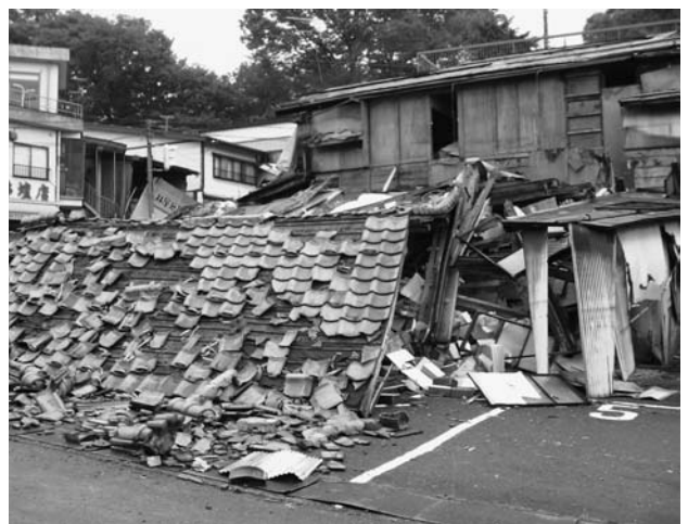
新潟県中越地震（平成16年10月23日、最大震度7）で倒壊した家屋＝小千谷市内、10月26日撮影
