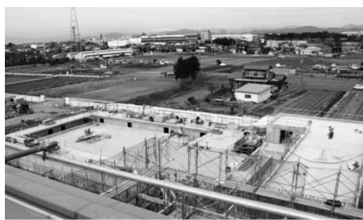
新校舍屋上から見た工事中の大口中学校プール。プールの下には雨水貯留槽が設置されている=20年1月22日、現地視察で
