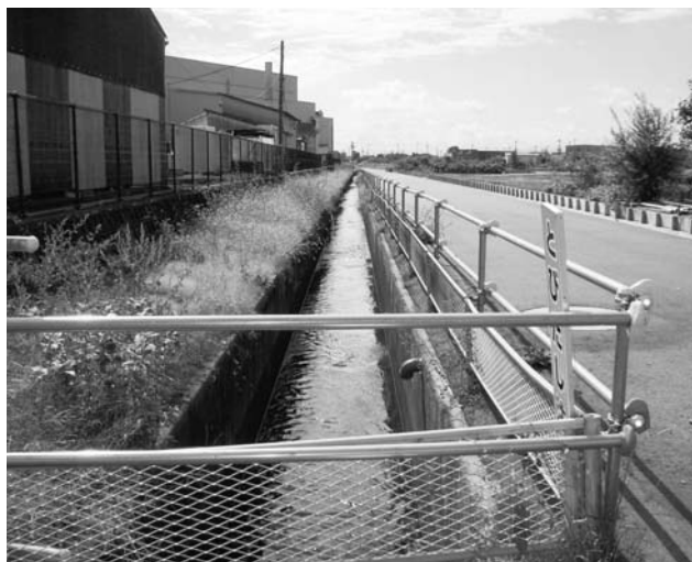
工事後は道路の下に埋設される昭和用排水路＝竹田一丁目、水路の左はヤマザキマザック（株）の建物
