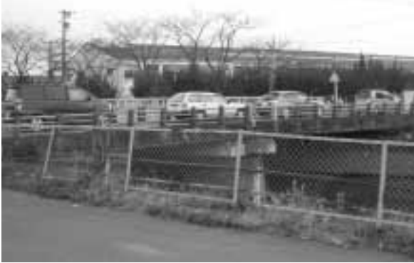
柿野橋には上流側だけ歩道橋がある。
