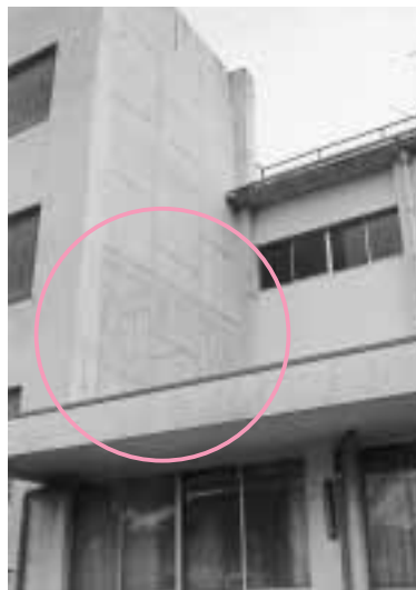
樹形図のような補修あと＝南小学校舎の外壁
