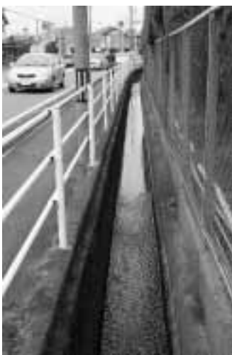
ふたが掛けられ、幅員が広くなる歩道＝兼房前の水路
