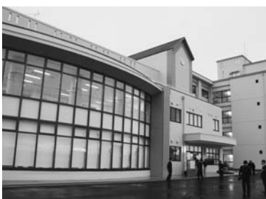
増築部分の北小学校校舎
