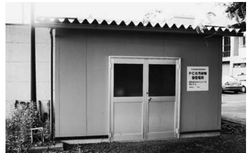
中央公民館南側の保管庫
