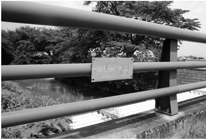
新田（あらた）橋の欄干に残った橋名板の台座。県管理分を合わせると、大口町内で7橋が「名無しの権兵衛」橋に？
