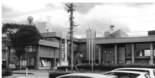
対策が必要な中央公民館
