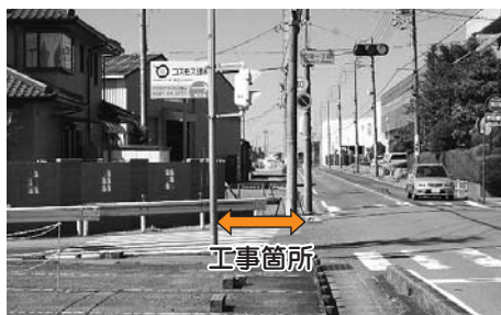
道路南側の整備現場=10月4日撮影
