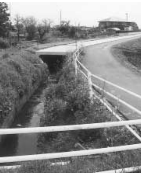
工事予定の郷浦排水路
