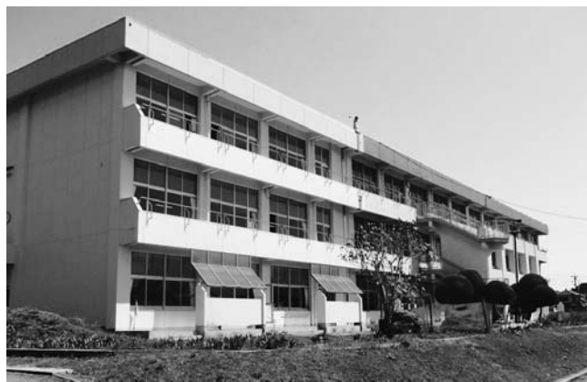
従前のガラスが使用されている西小学校
