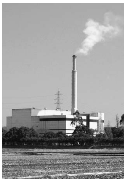
河北にある江南丹羽環境管理組合のごみ焼却処理施設
