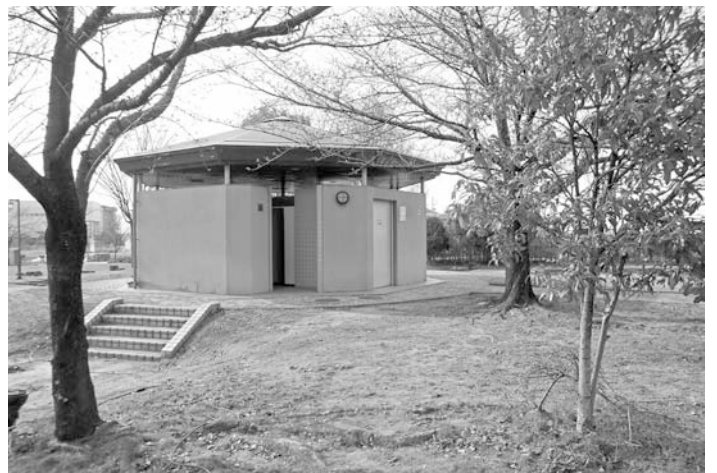
改修予定の堀尾跡公園のトイレ
