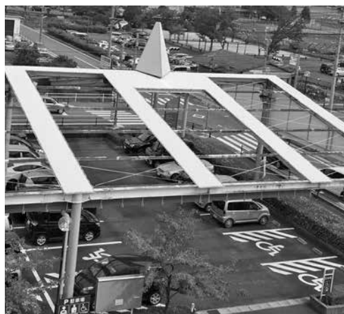
健康文化センター北側駐車場の屋根
