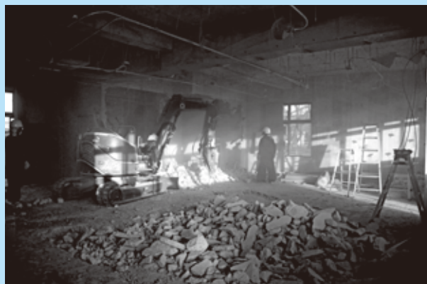
12月14日 工事中の室内には重機が
