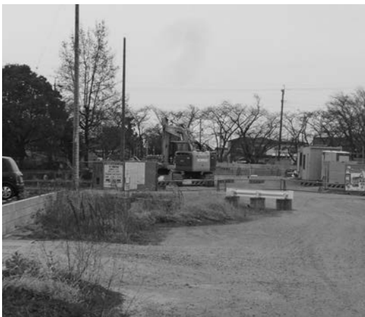
工事が進められているが道路予定地には雑草も
