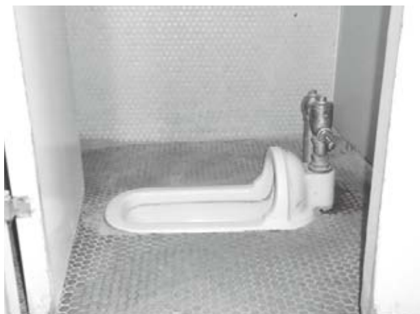
改修が望まれる西小のトイレ
