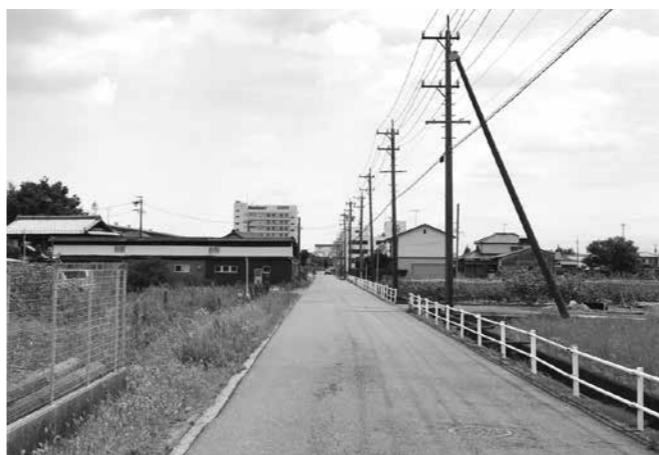
今年度、工事が予定されている町道秋田21号線
