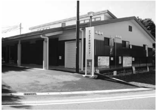
地域指定避難所のさつきヶ丘防災センター
