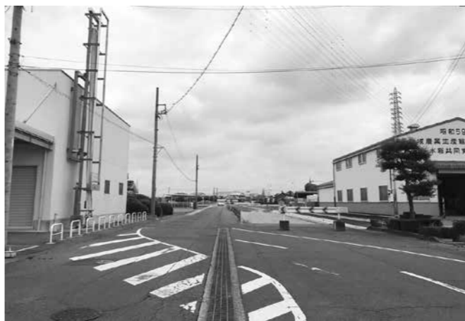
今年度の工事を見送ることになった町道役場前線
