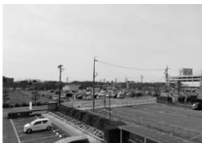
本庁舎勤務の職員が利用する町民会館駐車場（奥）
