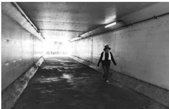
危険とされる国道41号下トンネル
