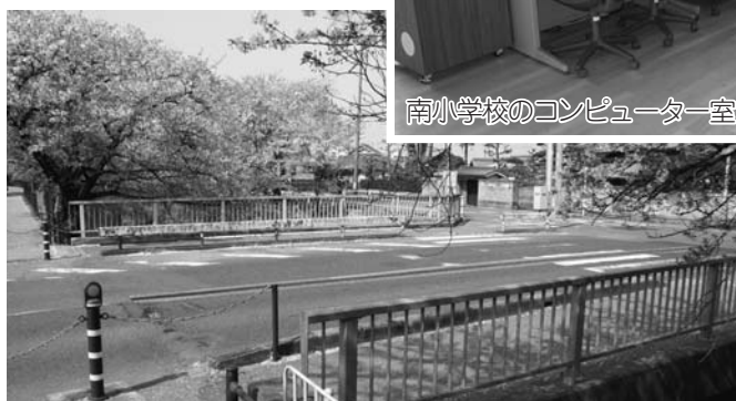
修繕工事予定の五条橋（大屋敷二丁目地内）
