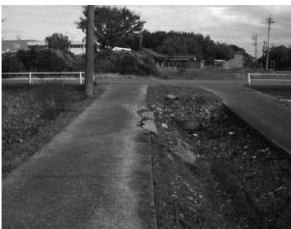
老朽した道路、排水路
