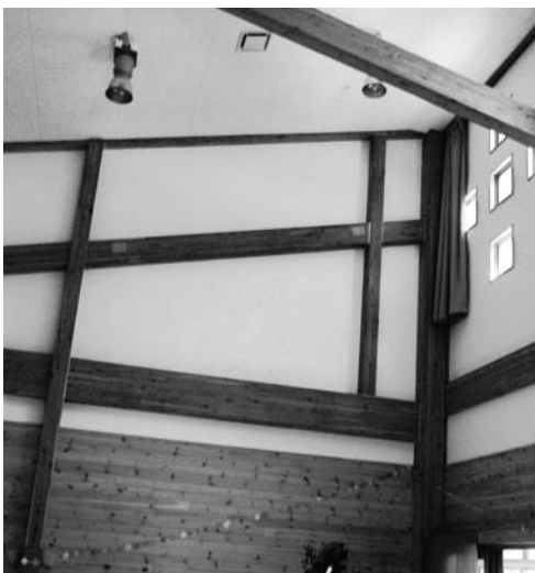
新町保育園の木造吹き抜け天井
