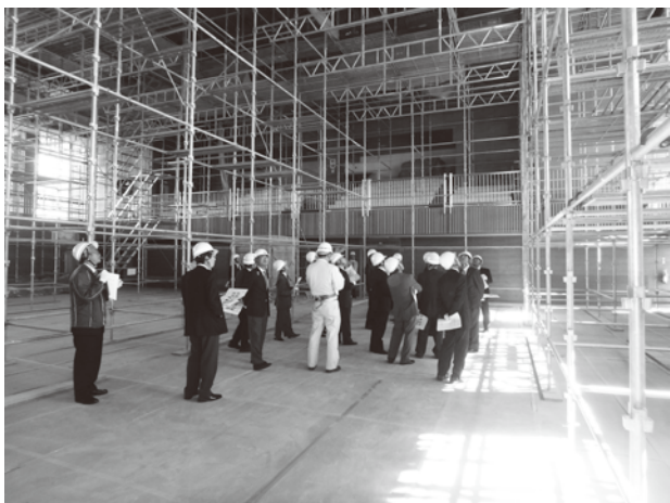
中央公民館集會室の耐震工事の様子
