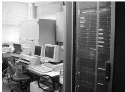
庁舎内の電算システム
