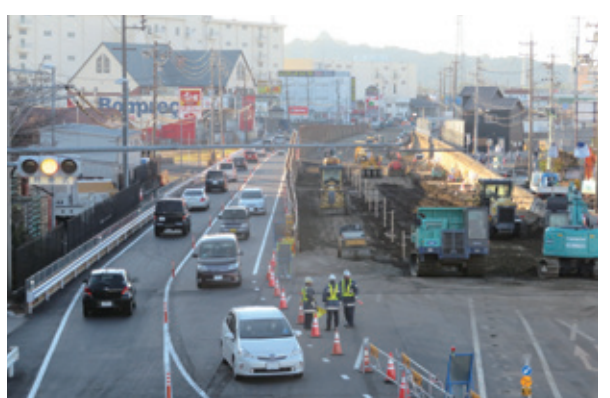
▲昨年度の工事の様子
