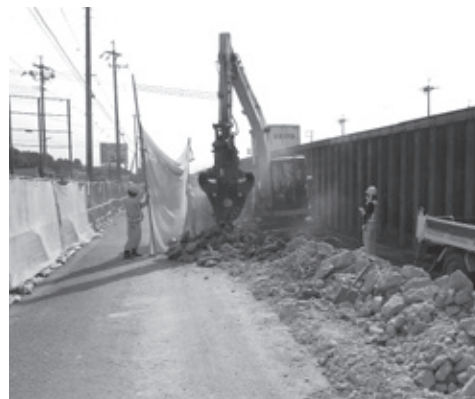
▲6車線化工事が進む国道41号線(外坪)
