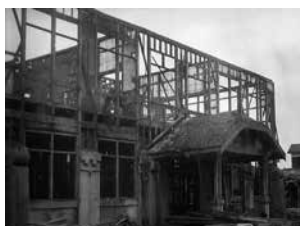
▲校舎解体（昭和32年） 写真提供 尾北高等学校
