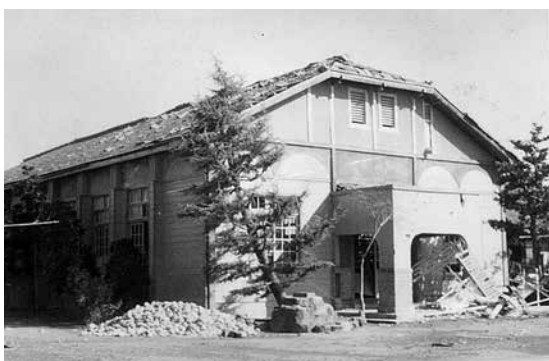
▲屋根の瓦をはじめ大きな被害を受けた講堂
