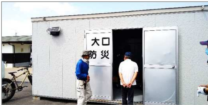
【西小学校防災倉庫点検】
