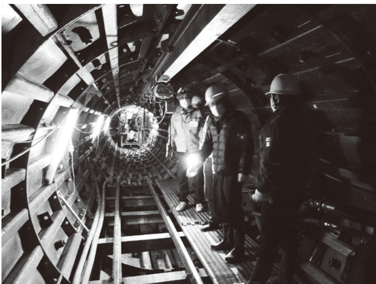
採掘された地下放水路内の様子。レールが敷かれ、土砂の運搬にトロッコが用いられています
