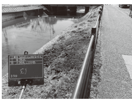
台風により倒れて処理される五条川の桜の様子(右側写真)。切り株を伐根後は、きれいに整地されました(左側写真)(下小口地内)
