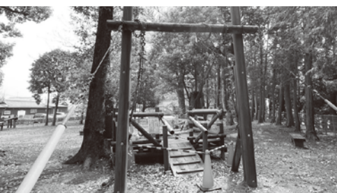
木が腐食して使用できなくなった遊具
