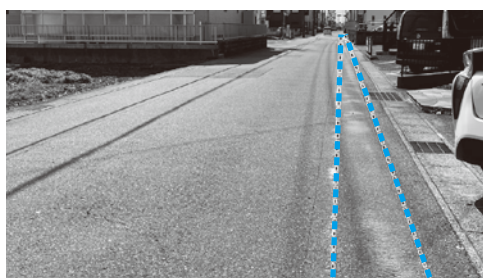
再塗装されるグリーンベルト(破線内側)
