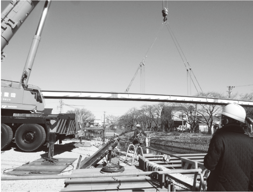
クレーンで橋桁を吊り、組み立てていきます
