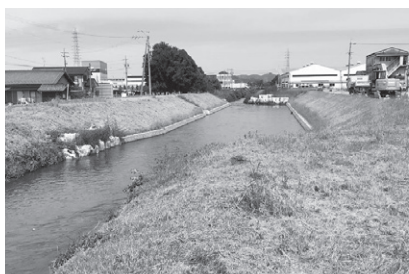
拡幅工事が進められている合瀬川
