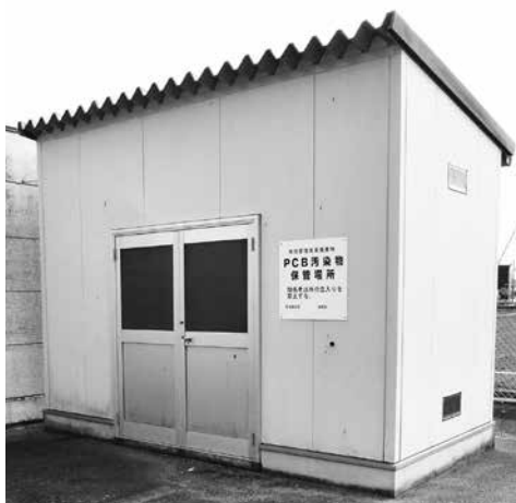
過去に町有施設で確認されたPCB廃棄物は、適切に処理するため中央公民館敷地内に一時的に保管されています
