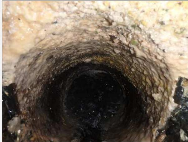
管に付着した汚れが確認できる。将来的に詰まりが発生する恐れがある。
