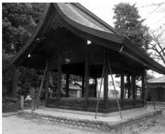
▲金属製の支柱が柱に固定されている八剣社拝殿
