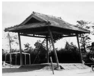
▲伊勢湾台風で瓦が飛び、柱が傾く相撲場(大口北小学校)
