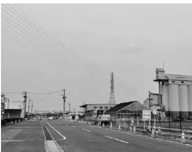
左：現在の町道役場前線のバス停（右側手前）付近の様子。町道小口線（左側奥）と接続することで交通量の増加が予想されます
