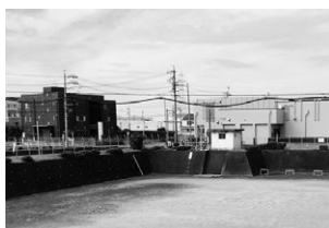
余野地区と下小口地区の堺付近にある調整池。豪雨時には満水になることも
