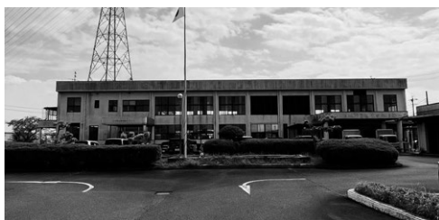
役場東側にある給食センターの外観(昭和63年竣工)
