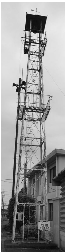
老朽化し安全性が懸念されている火の見櫓
