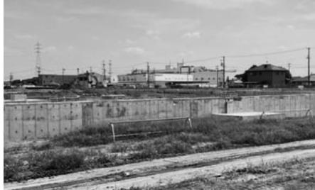
誘致した工場の造成が進められています
