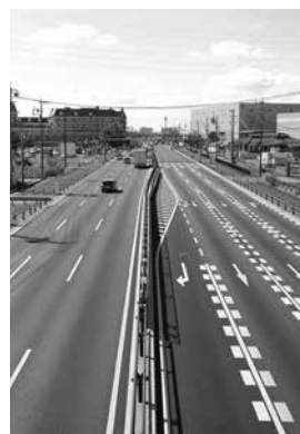
▲国道41号6車線化
