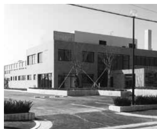
▲大口町温水プール(現オークマ温水プール)
