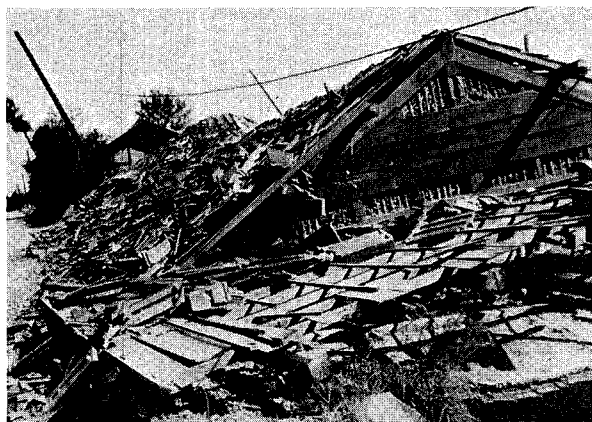
図1-30 伊勢湾台風により倒壊した大屋敷分館
