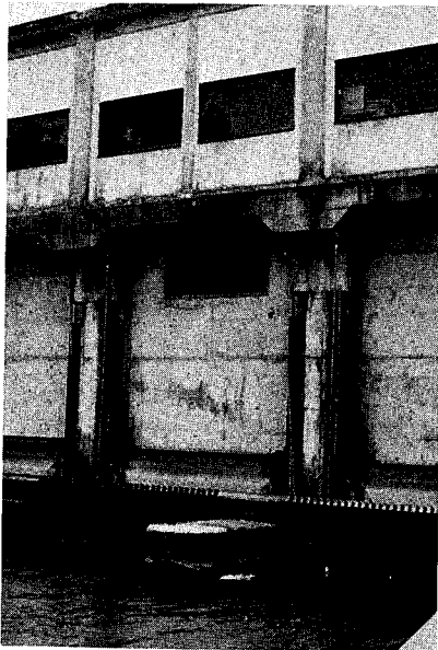
図3-42 木津用水取水閘門
