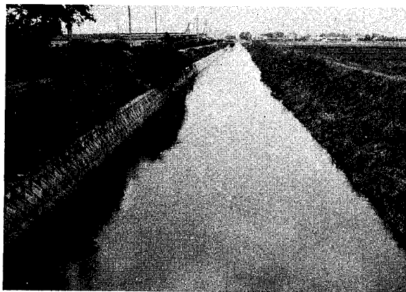
図3-44 合瀬川(古木津用水) (外坪大長橋より上流を望む)
