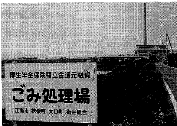
図3-84 ごみ処理場(大口町大字河北地内)
