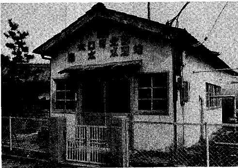
図3-96 簡易水道施設と水源地
