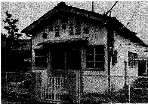
図3-96 簡易水道施設と水源地
