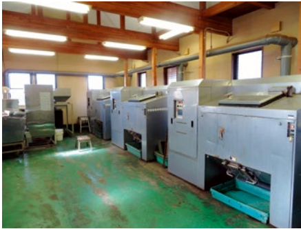
2-2-71 河北エコステーションの 外観（上）と内部（下）
