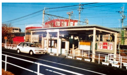
2-2-29 柏森駅南仮駅舎
