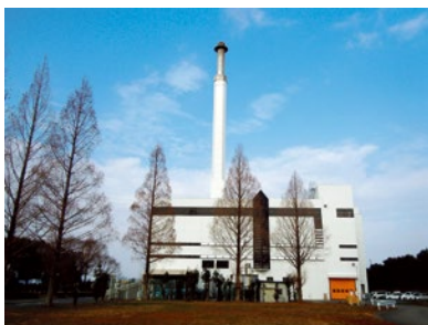
2-2-64 更新された環境美化センター （ごみ焼却施設・粗大ごみ処理施設）
