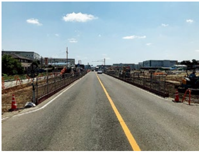
2-2-49 国道155号拡幅工事（2022年撮影）
