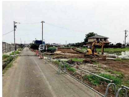
2-2-50 愛岐南北線の工事（2022年撮影）
