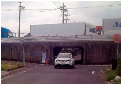
2-2-45 工事前の高架 (2016年)
