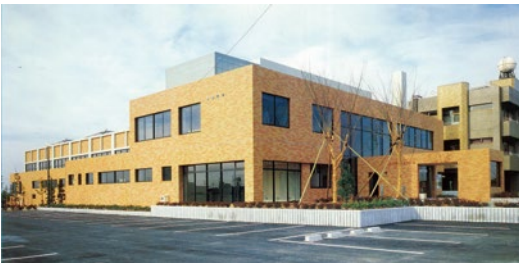
2-3-56 温水プール （『大口町温水プール竣工リーフレット』）
