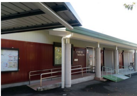
2-3-12 さつきヶ丘防災センター (2022年撮影)
