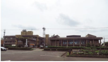
2-3-54 大口町中央公民館（旧総合福祉会館） （2022年撮影）
