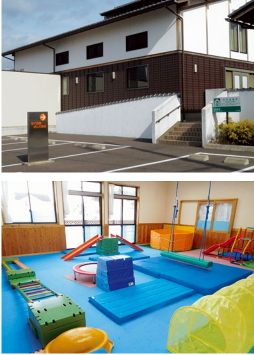
2-4-18 親子通園棟の外観と内部
