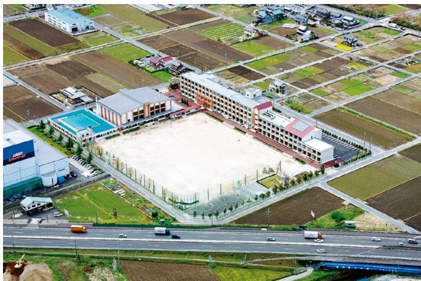
2-4-39 大口北小学校全景（2010年）
