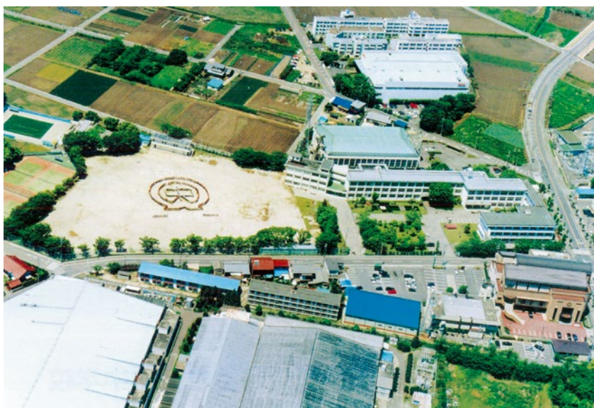
2-4-49 大口中学校全景（1997年）
