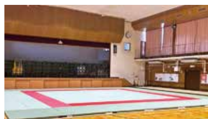
北防災センター内アリーナの様子 天井にはシーリングファンが設置されている
