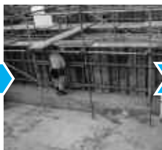
▲地下ピット部分の型枠立ち上げ
