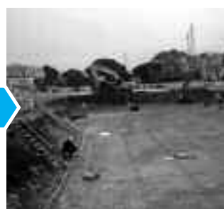
▲基礎工事の準備
