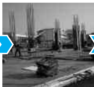
▲1階部分の柱工事
