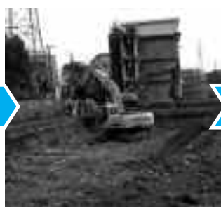
▲基礎工事のための掘削
