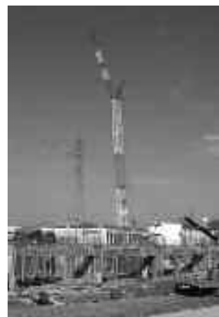
▲校舎1階部分の柱工事が おおむね完了
