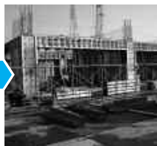
▲校舎南側の1階柱と梁工事
