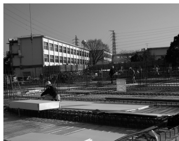
▲建設中の大口中学校
