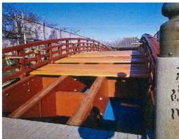
【施工中 床板設置】
