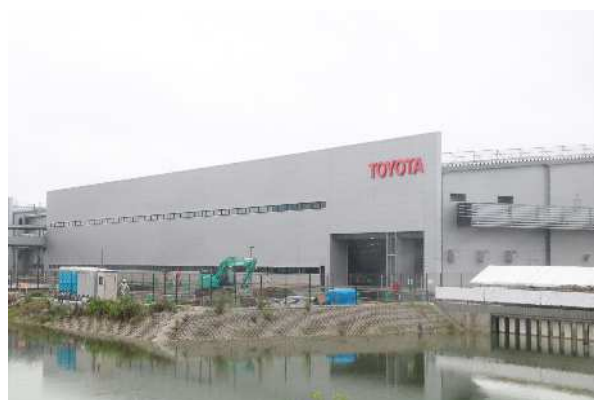
建設中のトヨタ自動車(株)新大口部品センター
