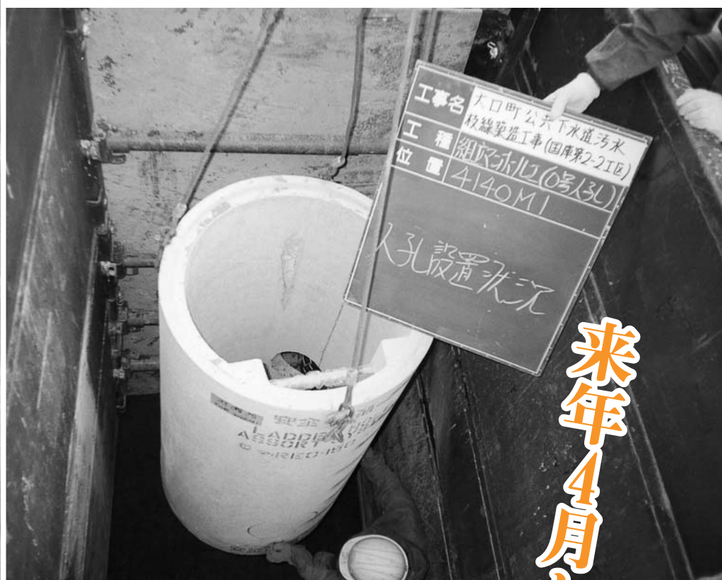
来年4月の供用開始に向け急ピッチで進む下水道工事 マンホール①と本管②=余野二丁目地内
