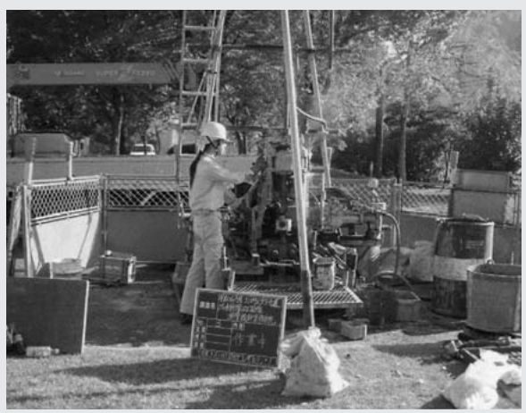
ボーリング調査で地質確認
