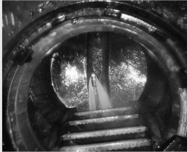
ジェット水流で下水道の管路清掃
